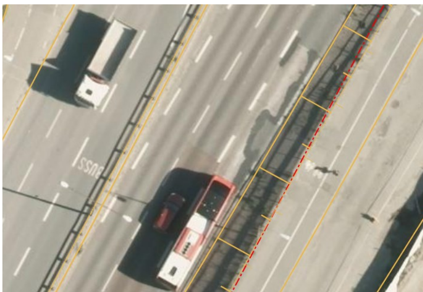
Figur 3. Roslagsvägen söder om Greta Arwidssons Väg. Ny fastighetsgräns i rött till vänster om befintlig GC-bana.
