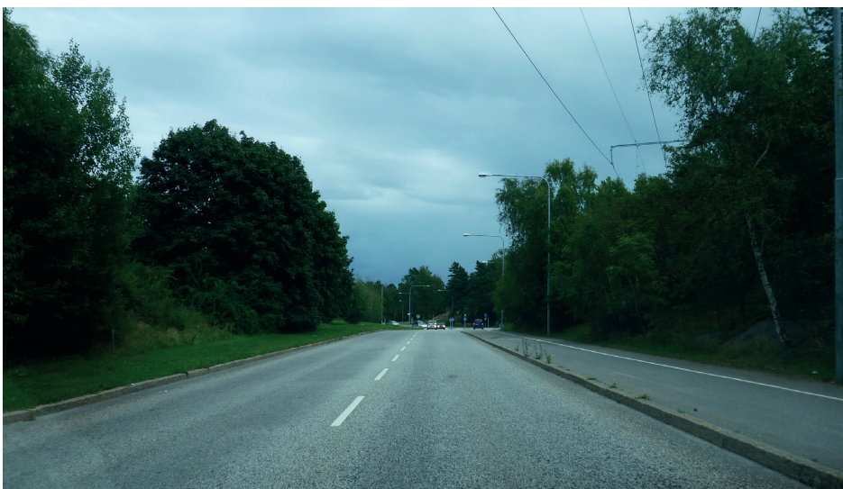
Kontrollvägen vid Diamantbacken, riktning norrut
