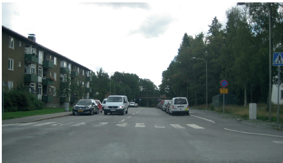
Folkparksvägen vid Pliggvägen, riktning söderut. Bilden tagen innan cykelbana byggts ut.
