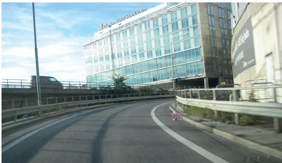
Södergatskopplet, riktning norrut
