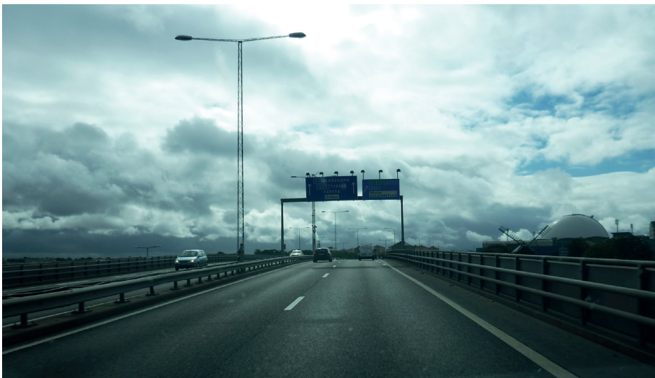
Johanneshovsbron, riktning söderut
