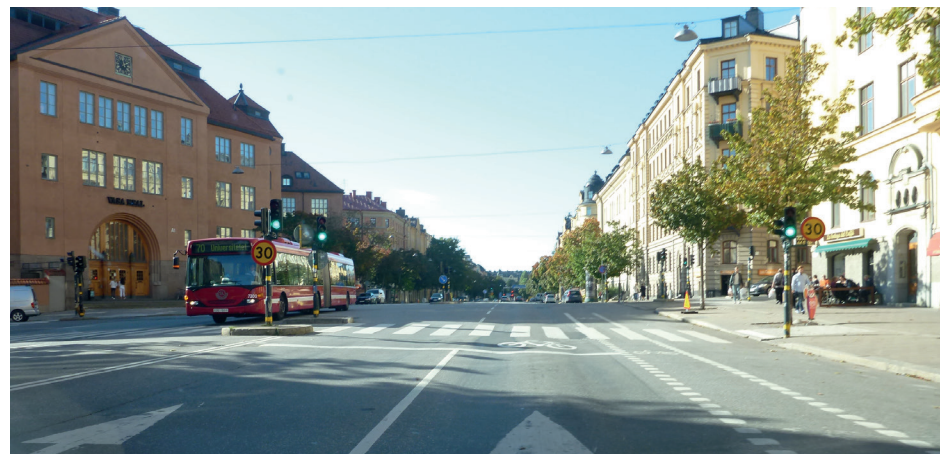
Karlbergsvägen, Norrmalm: Cyklister är separerade med en målad linje, vilket inte bedömts vara fullgod separering. Sträckan har klassats med DTSS gc/bil.
