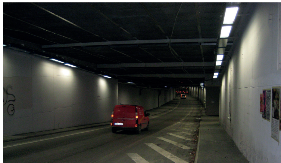
Söderledstunneln, riktning norrut
