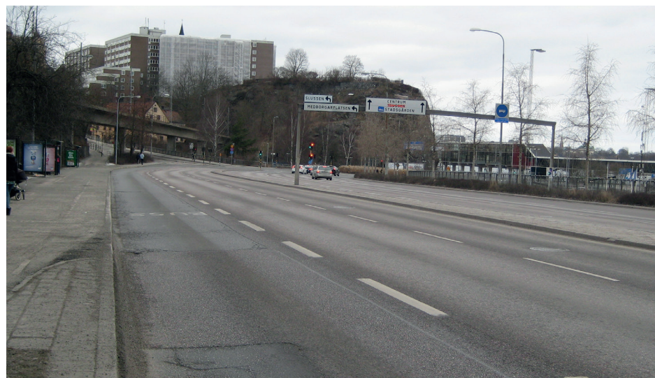
Värmdövägen ( mellan Folkungagatan och Kvarnholmsvägen)
