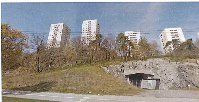
Naturen vid planerat läge för arbetstunnelmynning vid Liljeholmen består av en bergssluttning med berg i dagen och med yngre lövträd
