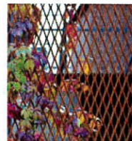
Räcken av brun perforerad plåt
