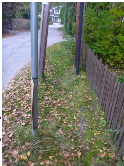
Bild 3. Dike längs med Klockvägen med kupolbrunn. Diket avvattnar Klockvägen.
