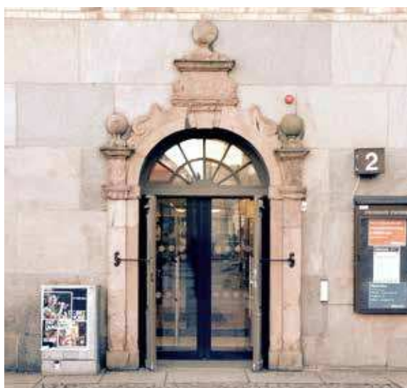
Exempel på energiförbättring i ett äldre dörrparti vid Medborgarplatsens bibliotek
