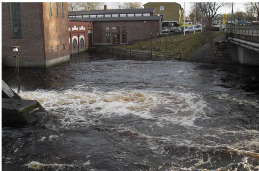
Ljungby Energi vid Vislandavägen.
