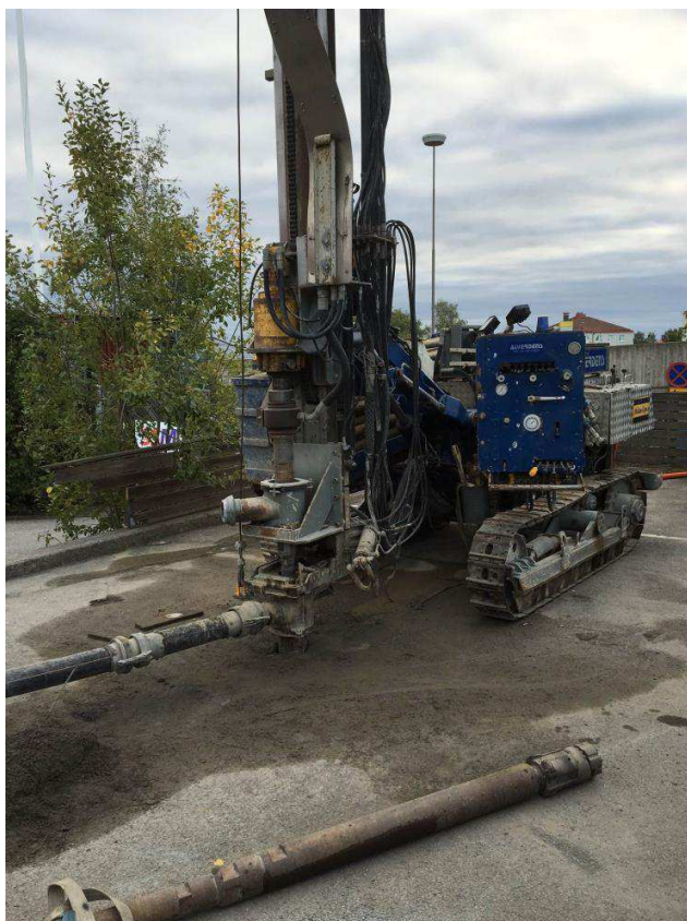
Foto 1. Pågående borrhingsarbete vid grundvattenrör RGS01
