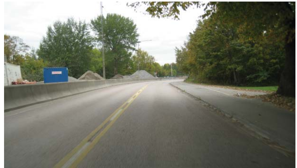
Johanneshovsvägen vid Bolidenvägen, riktning västerut
