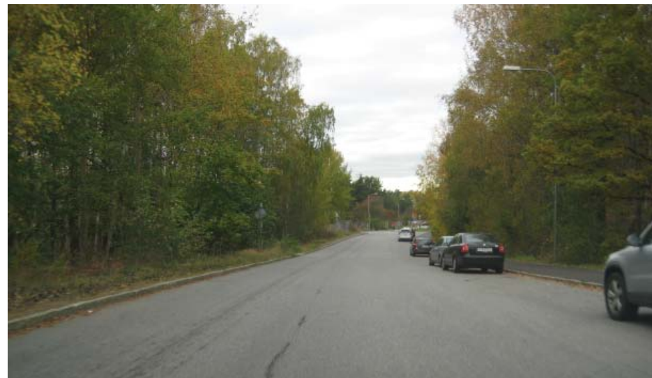
Majrovägen vid Getfotsvägen, riktning västerut
