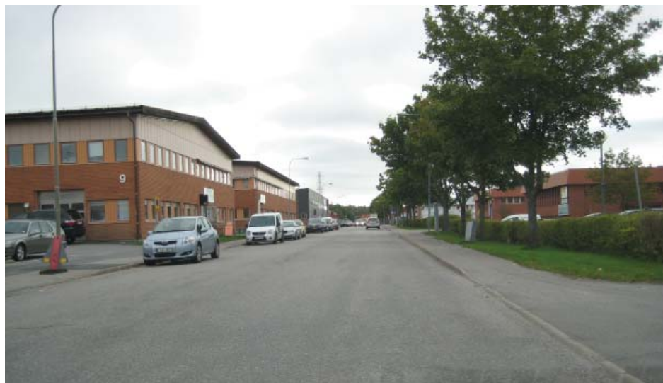
Flygfältsgatan vid Flygledargatan, riktning österut
