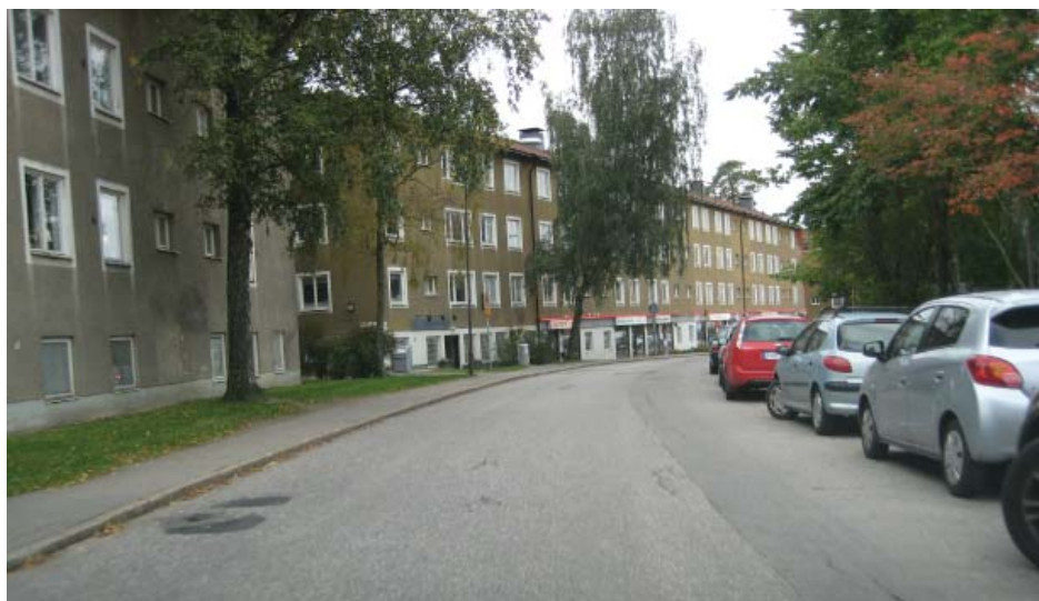
Kärrtorpsvägen vid Vikstensvägen, riktning söderut
