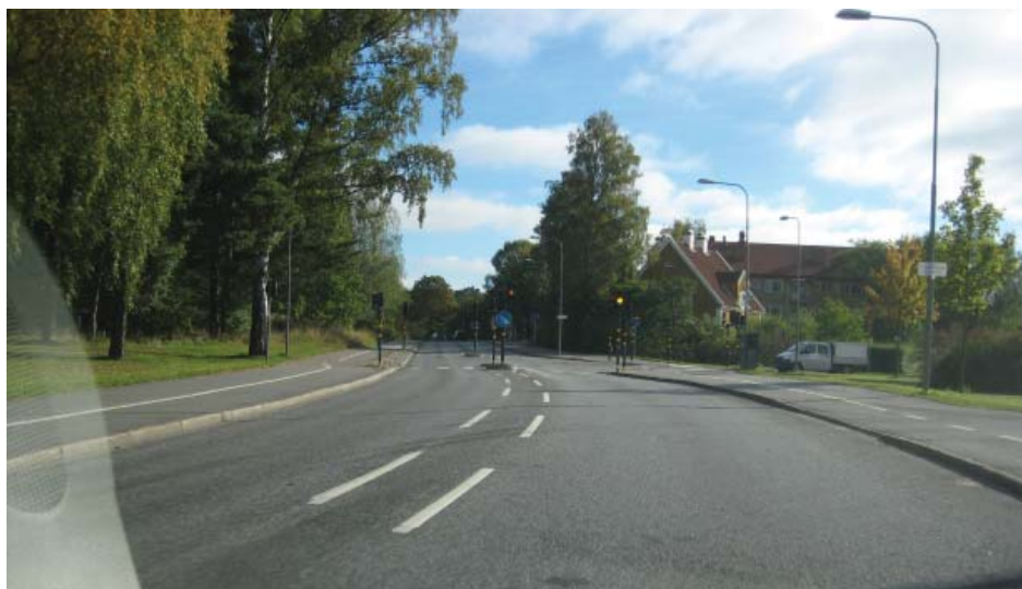
Sockenvägen vid Statsrådsvägen, riktning österut
