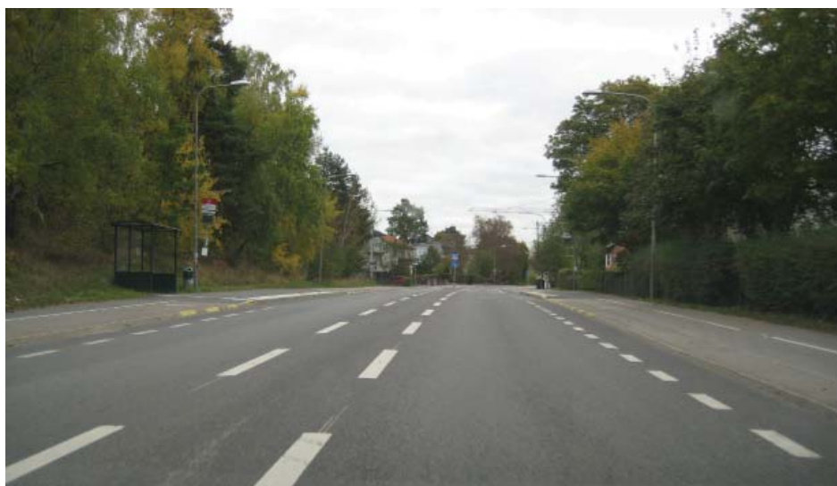
Grycksbovägen vid Söråkersvägen, riktning österut
