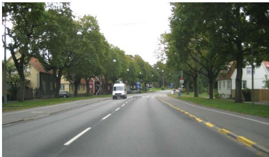
Gamla Tyresövägen vid Hagtornsvägen, riktning söderut
