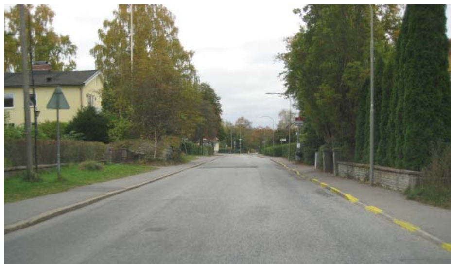
Sköldingevägen vid Hyltingevägen, riktning söderut
