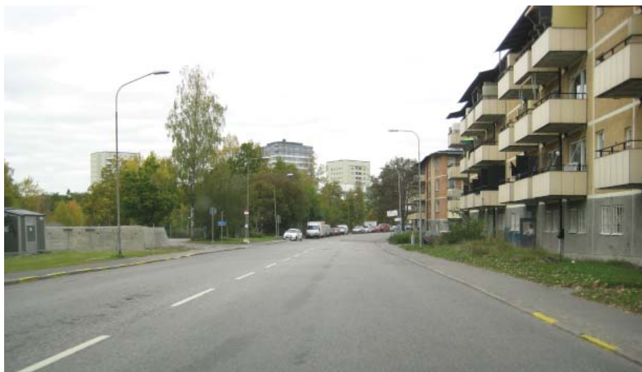
Harpsundsvägen vid nr 143, riktning norrut
