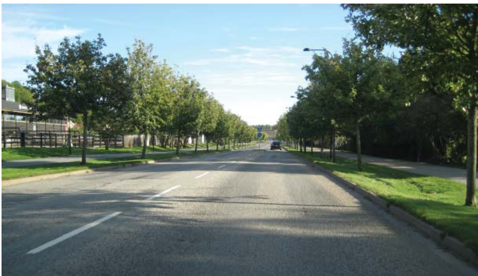
Sockenvägen vid Bägersta Byväg, riktning österut
