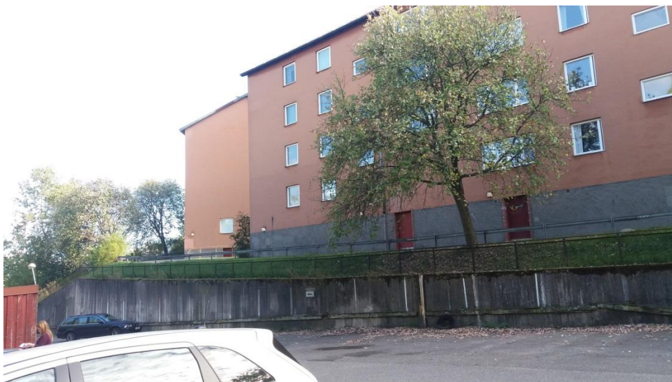
Figur 9 Höjdskillnaderna har hanterats genom att anlägga stödmurar (Bildkälla: WSP)
