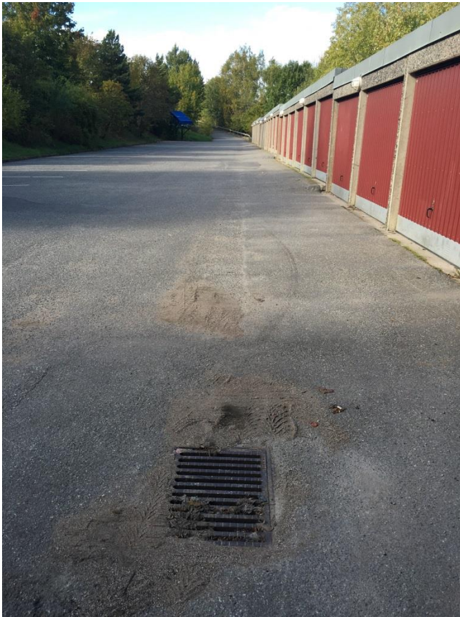
Figur 8 En stor del av området består av parkeringar som avvattnas till det allmänna dagvattenledningsnätet (Bildkälla: WSP)
