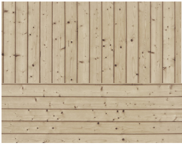
M4- Övriga fasader. Stående och liggande panel av trä.
