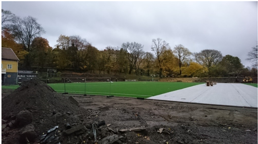
Markschakt och demontering av konstgräs är påbörjad. Bilden är tagen i oktober 2016.
