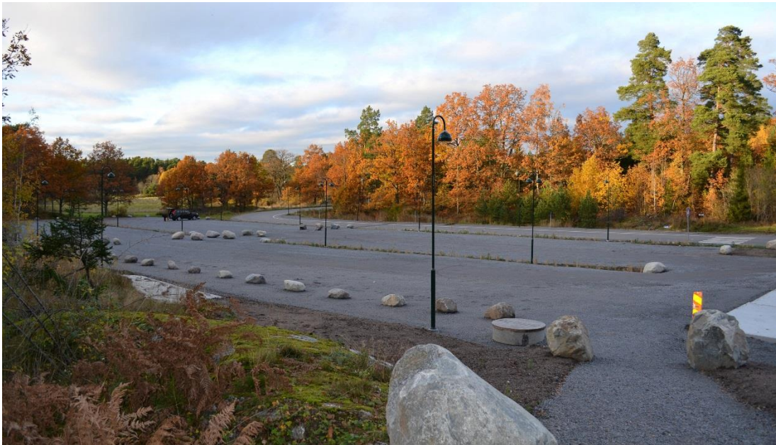
Figur 16: Fotografi av den befintliga parkeringen.
