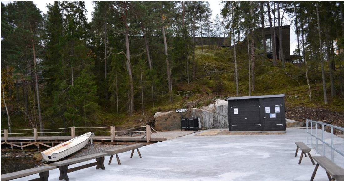
Figur 17: Plats för servicebyggnad. Platsen är bebyggd med toalettbyggnad för vilken strandskyddsdispens har beviljats 2012-01-23.
