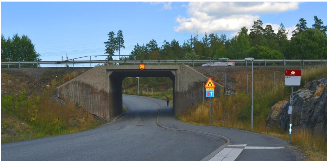
Figur 19: Befintlig vägtunnel för Hålluddsvägen under Värmdöleden.
