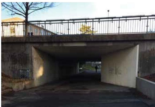
Att tunneln vidgas vid öppningen är positivt ur trygghetssynpunkt
