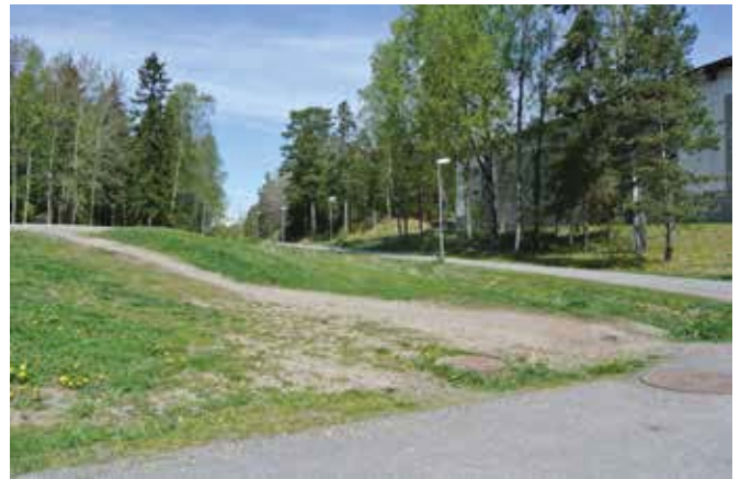
Upptrampad stig upp på dagvattenmagasinet. Dalhallen i bakgrunden
