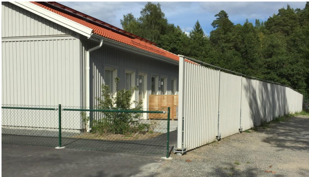
Bilden visar det bullerplank som uppförts strax framför de boendes lägenheter och uteplatser.
