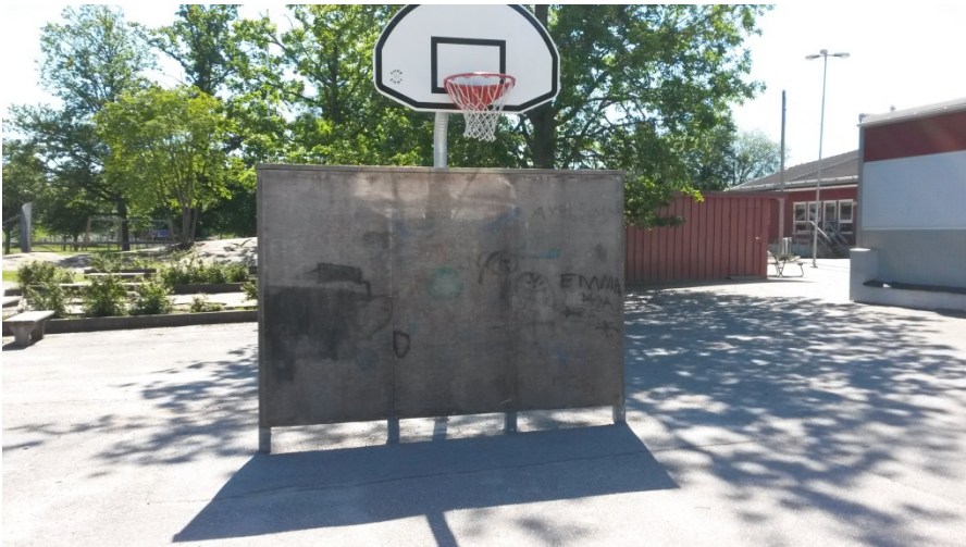
Figur 3: Västra delen av skolgården är i huvudsak asfalterad.
