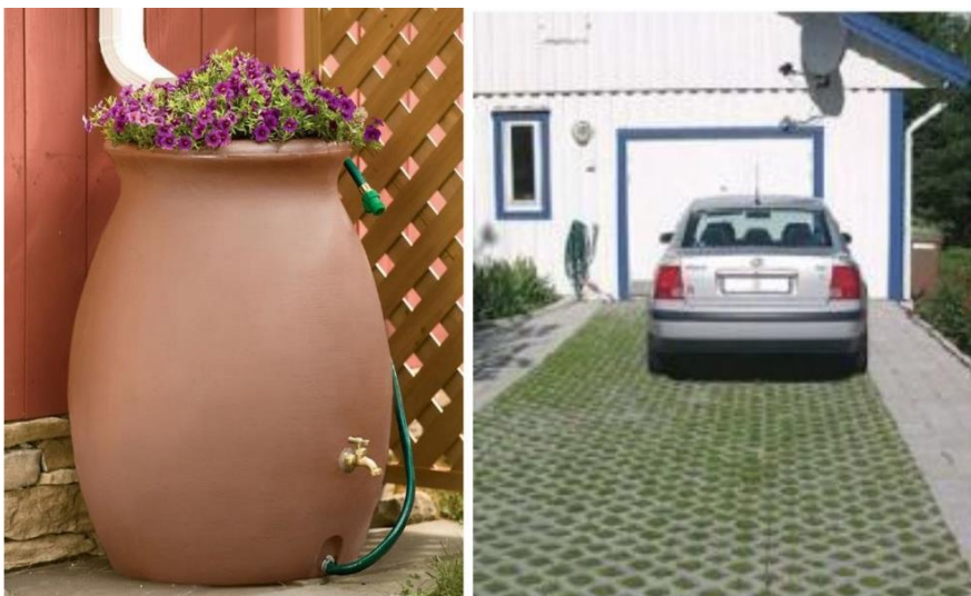
Figur 11. Exempel på lösning för omhändertagande av dagvatten på tomten och permeabel beläggning med exempelvis betong med hål som kan fyllas med material som tillåter infiltration av dagvatten.
