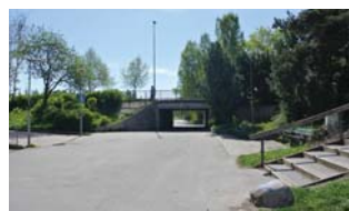
3. Gång- och cykeltunnel under Bollmoravägen
