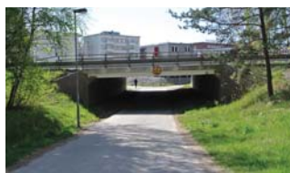
1. Gång- och cykeltunnel under Tyresövägen
