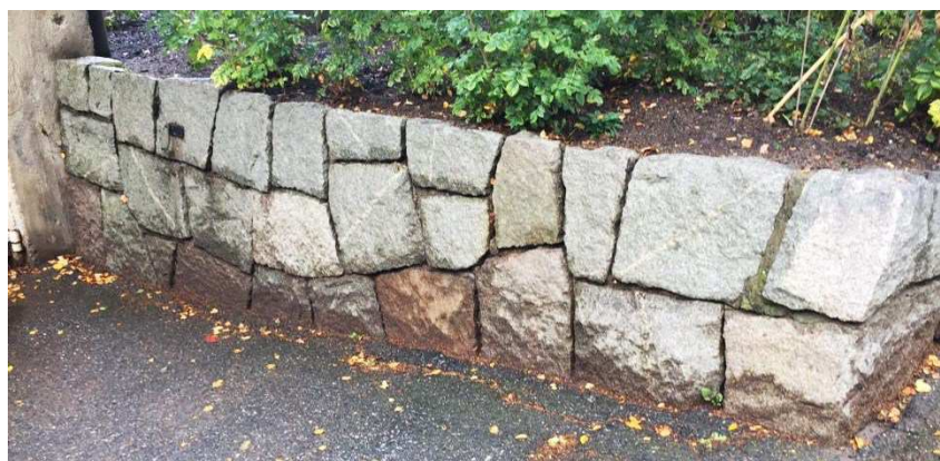
Granitmur i direkt anslutning till planområdet vid nedfart till garage som finns i gavlarna som vetter mot den planerade bebyggelsen.
