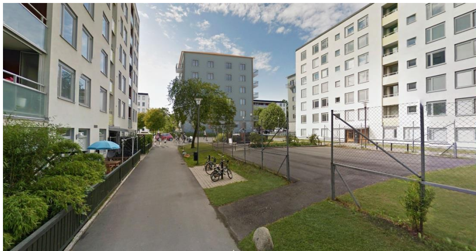
Perspektivbild, vy från norr. Ett av de nya punkthusen syns mellan två befintliga skivhus på fastigheten Bjurö 1. Bild: ÅWL Arkitekter
