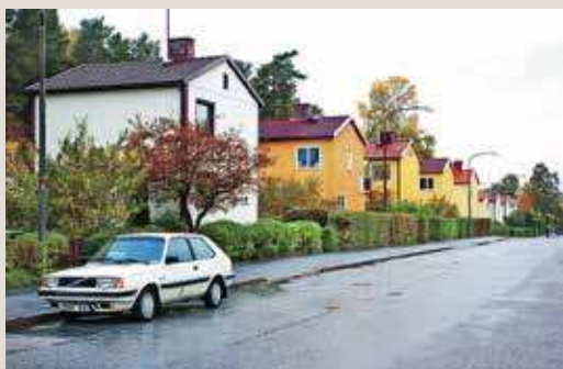
Tvåvåningsvillor Enskede. Foto: Lennart Johansson Källa: Stadsbyggnadskontoret
