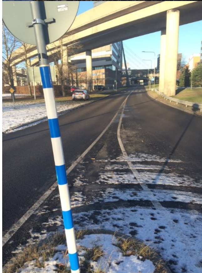
Hanstavägen med ny beläggning
