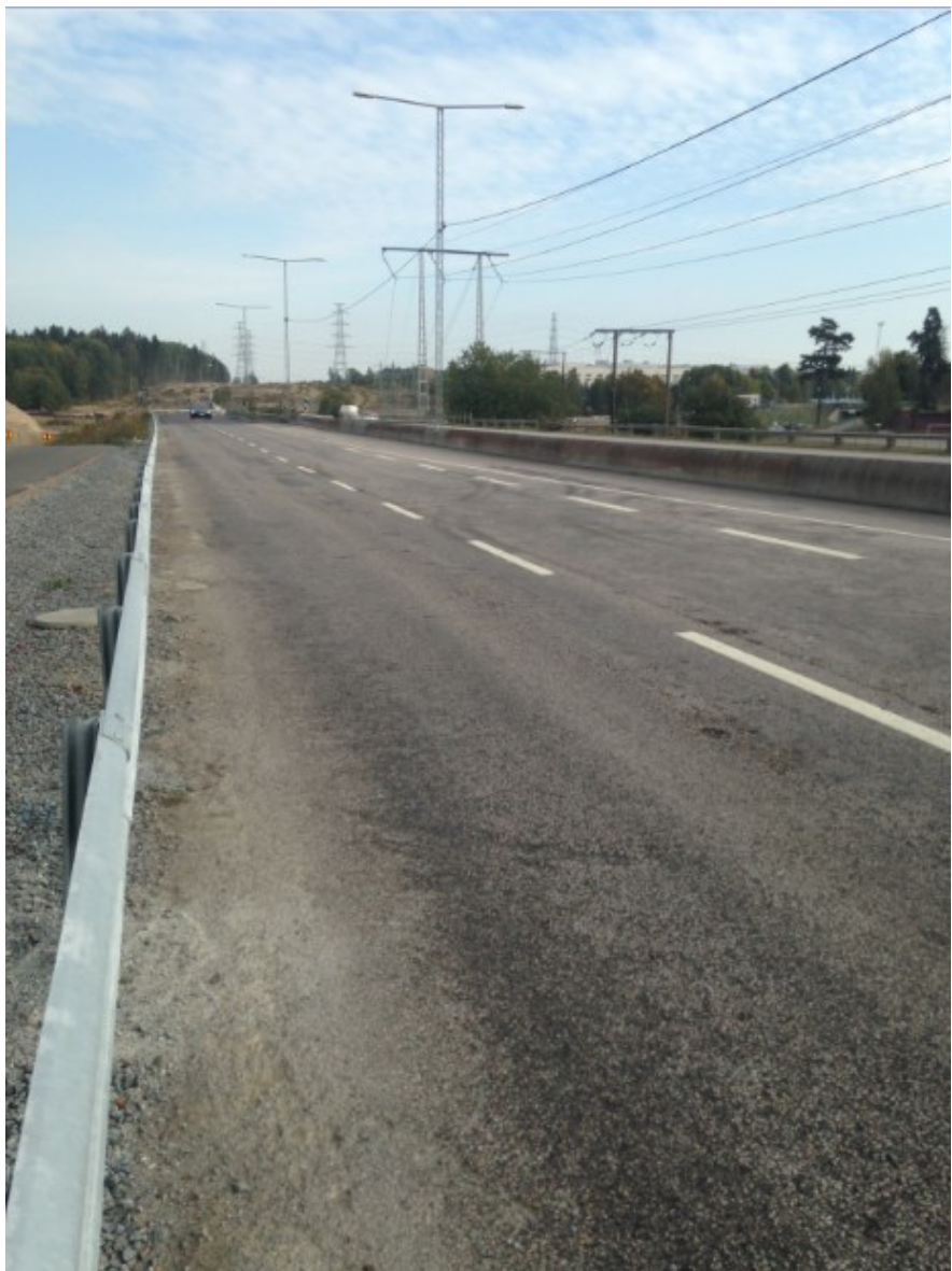
Akallalänken innan ny beläggning
