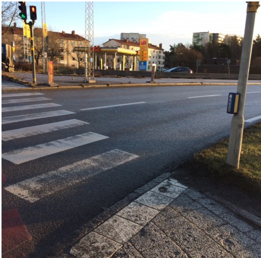
Bergslagsvägen efter åtgärd
