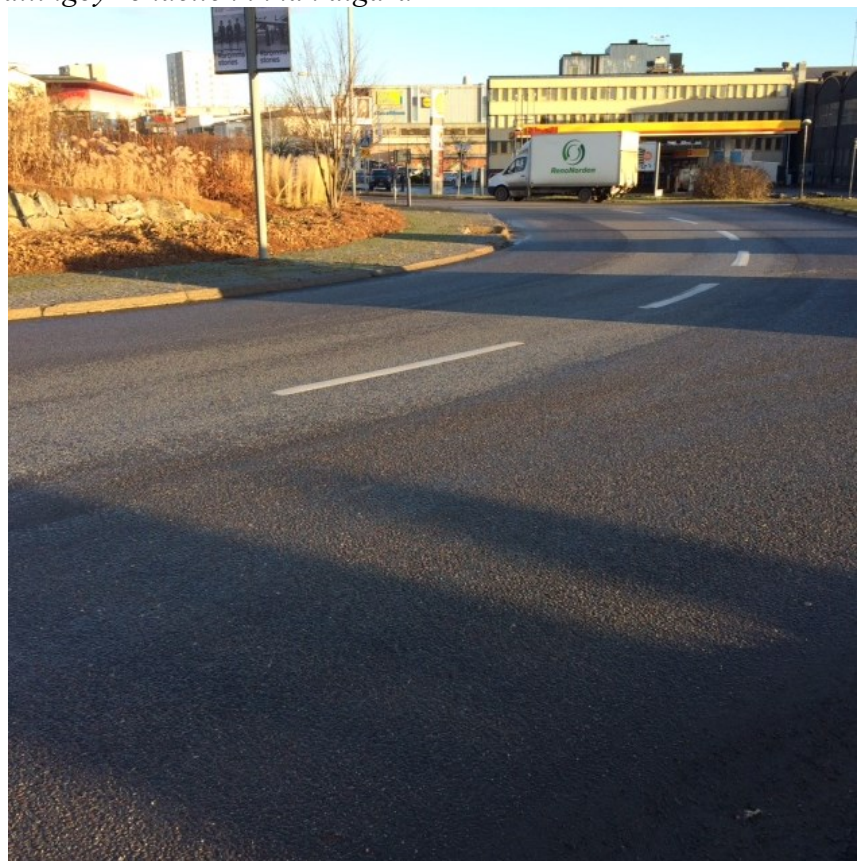
Vällingbyrondellen efter utförd åtgärd
