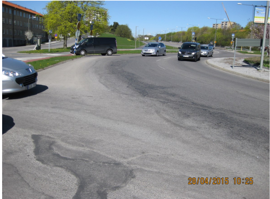
Vällingby rondellen innan åtgärd
