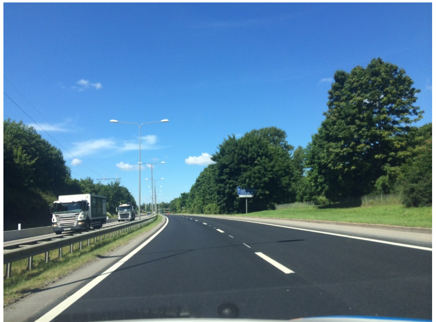
Nybeläggning på Örbyleden
