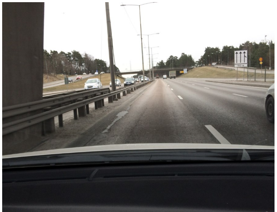
Bildexempel Nynäsvägen innan åtgärd
