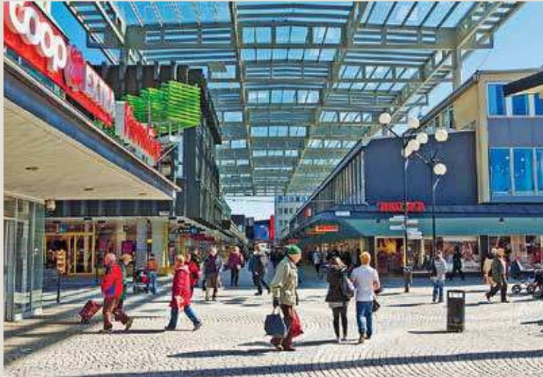
Vällingby Centrum. Ursprungliga byggnader och offentligt rum med bevarad karaktär har kompletterats med ett nytt, högt upplyft tak.
