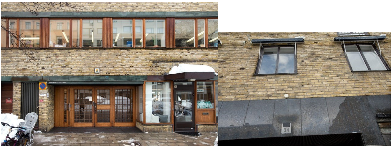
Detaljbilder över orten mot Västmannagatan (till vänster) respektive bottenvåningen mot Dalagatan (till höger). Byggnadernas kvalitéer är det gula teglet, träinslagen i entré -partier och fönsterpartier i fasaden mot Västmannagatan samt beklädnaden med svart granit i fasaden mot Dalagatan.
