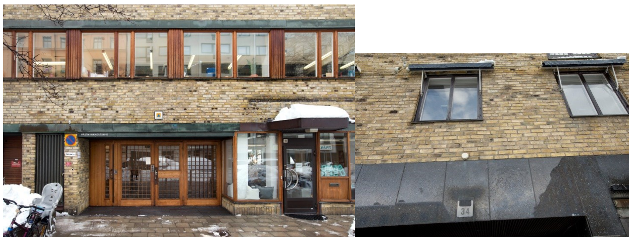
Detaljbilder över orten mot Västmannagatan (till vänster) respektive bottenvåningen mot Dalagatan (till höger). Byggnadernas kvalitéer är det gula teglet, träinslagen i entré -partier och fönsterpartier i fasaden mot Västmannagatan samt beklädnaden med svart granit i fasaden mot Dalagatan.
