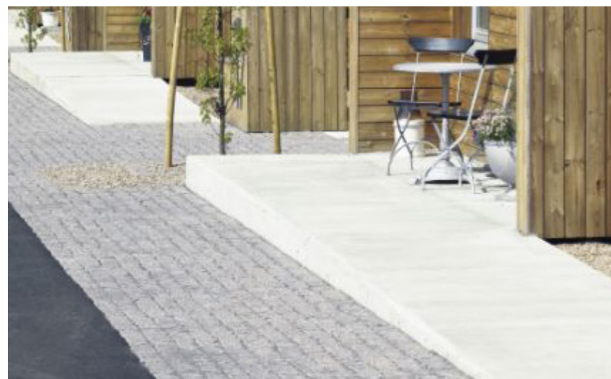
Referens genomsläppligt markmaterial, samt entréstege i betong. Referens: Pumpkällehagen av Viskaforshem.
