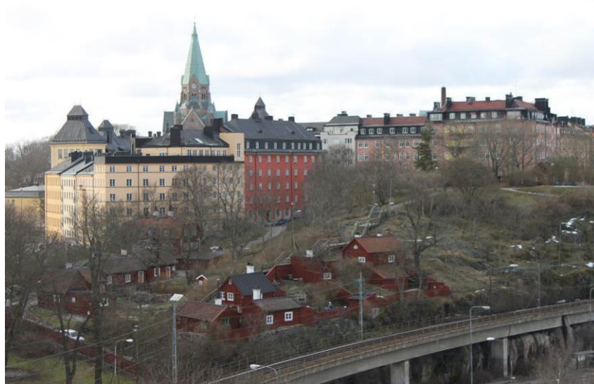
Stadsfront östra Södermalm och mötet med Åsöberget. Planområdet tar vid strax till vänster i bild. Stenstadens front har varierande taklifthöjd, gavlar, takkupor och frontespiser som bryter takfotslinjen samt torndelar som markörer. Planförslagets gestaltungsprinciper utgår från dessa motiv, men omsätter det till en modern tolkning.
