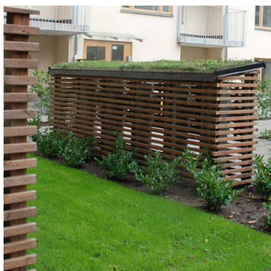
Sopsugsnedkast omhändertas i gårdens gestaltning (Tengbom)
