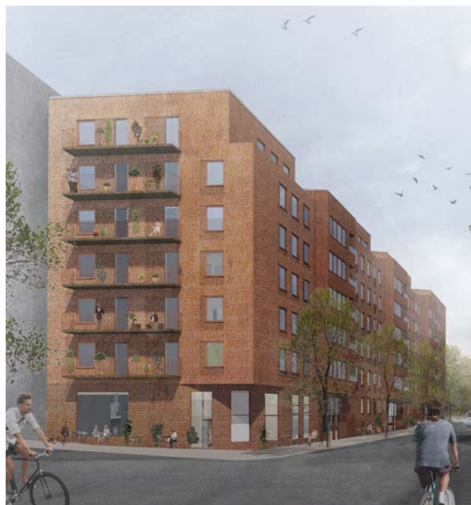
Vy (B) från korsning Bondegatans förlängning/Barnängsgatan
