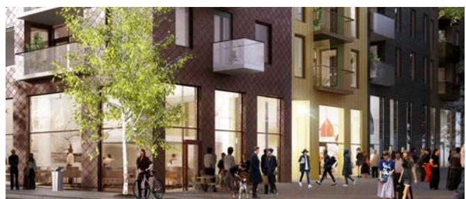
Balkonger med begränsat uthäng mot lokalgata men större uthäng mot Persikogränd. Exempel från kv 6a.
