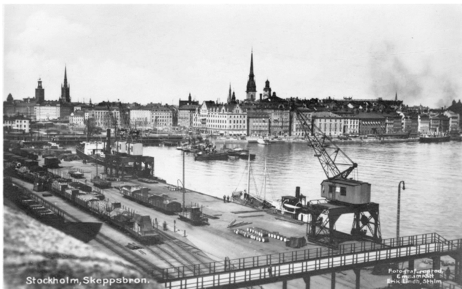
Figur 3. Stadsgårdens västra del, under 1920-tal- En bro över Saltsjöbanan och bangården kopplade Lokattens trappor med kajområdet. (Källa:Stockholmskällan)
