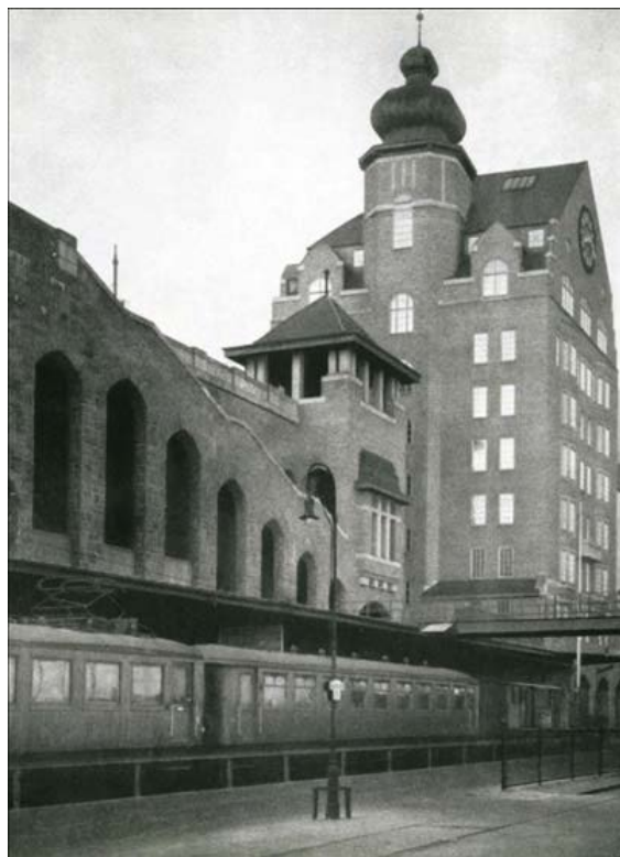
Fig 3,4. På den övre bilden ses murarnas och vilplanets spetsbågiga valv. Smidesräcken i jugendstil. Den nedre bilden visar byggnaden i början av 1900-talet då den fortfarande fungerade som slutstation för Saltsjöbanan. Trappan och murarnas karakteristiska spetsbågiga valv syns tydligt. Bild: Stockholms stadsmuseum (överst) respektive okänd (ovan).
