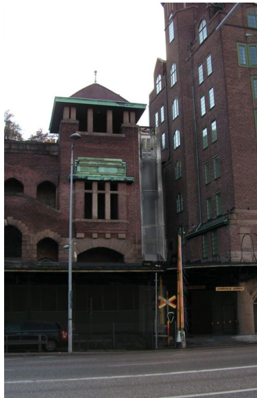
Fig 18. En hiss kommer att byggas mellan Sjömansinstitutet och Lokattens trappor som kopplar den högre nivån vid Katarinavägen med den lägre liggande Stadsgården. Bild: Link arkitektur
