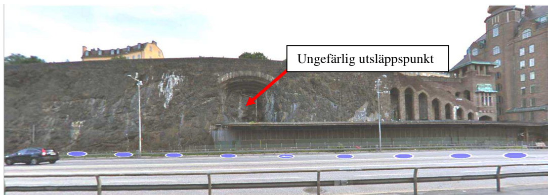
Figur 4. Ungefärlig plats för ventilationsutsläpp från bussterminalen i Katarinaberget, bild från Hitta.se.
