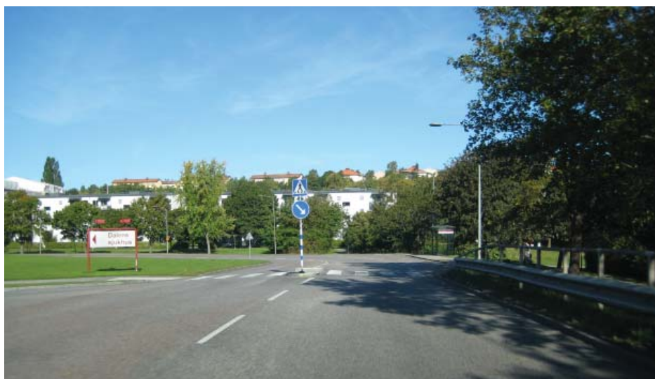
Åstorpsringen vid Fyrskjeppsvägen, riktning norrut
