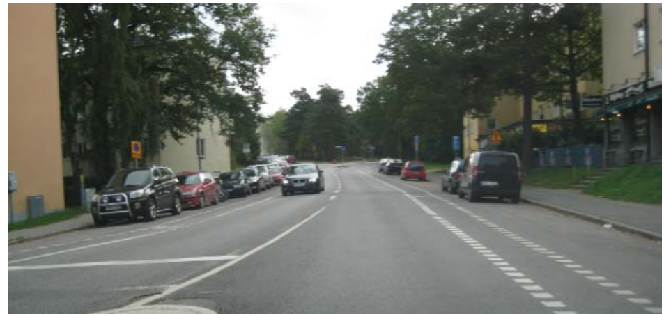
Olaus Magnus väg, Skarpnäck: Cyklister trafikerar ett målat cykelfält, vilket inte bedömts vara fullgod separering. Sträckan har klassats med DTSS gc/bil.
