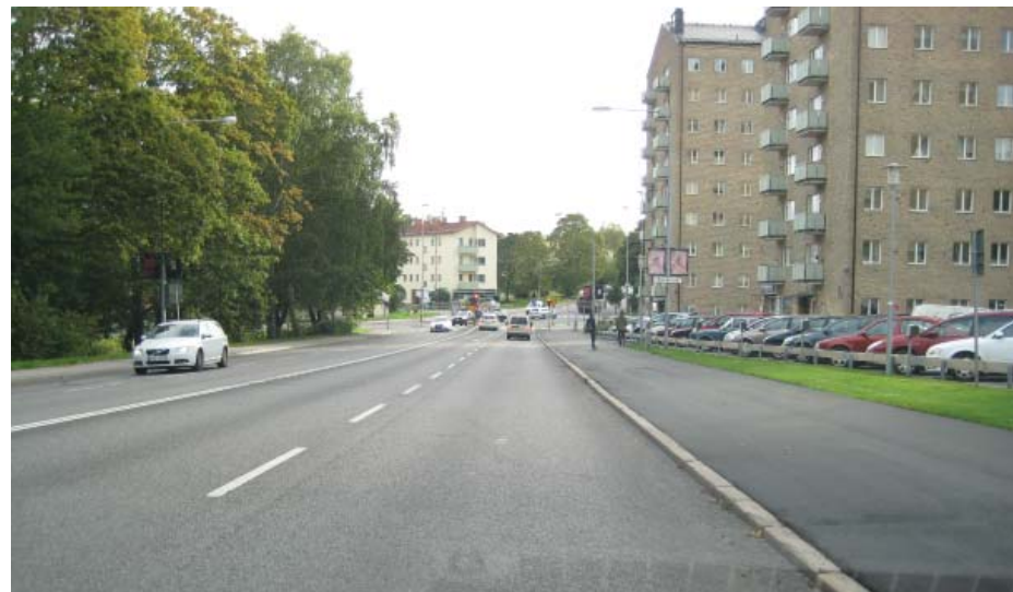
Olaus Magnus väg vid Hammarbybacken, riktning österut
