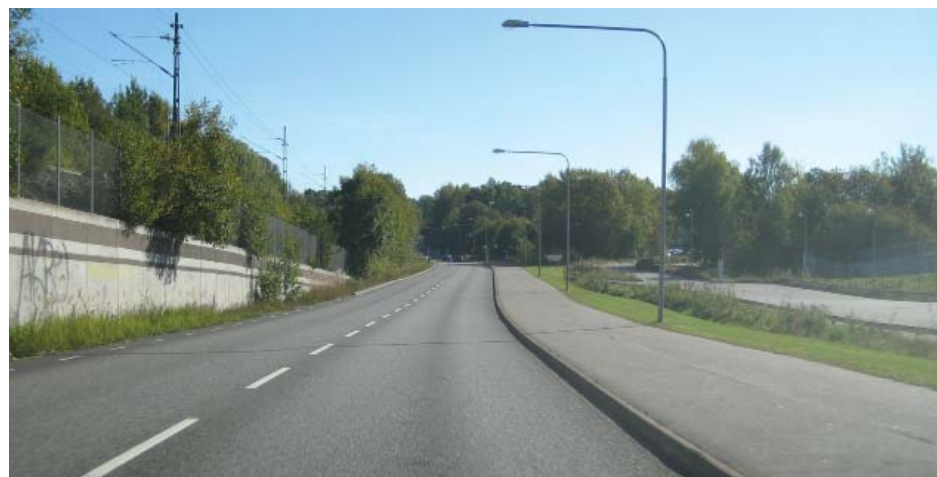
Trafikled med befintlig 50 km/tim (Magelungsvägen, Farsta).
