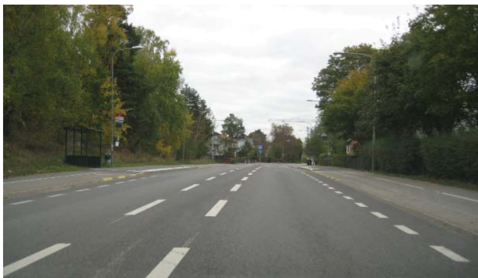
Grycksbovägen vid Söråkersvägen, riktning österut
