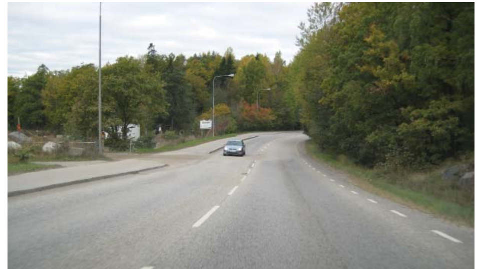
Magelungsvägen vid Snösättravägen, riktning norrut
