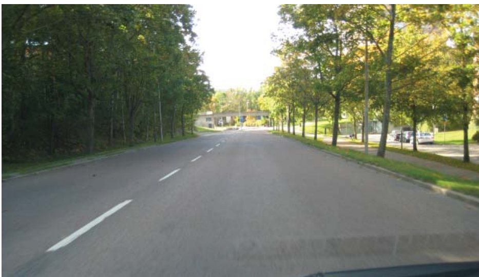
Norgegatan vid Stavangergatan, riktning söderut
