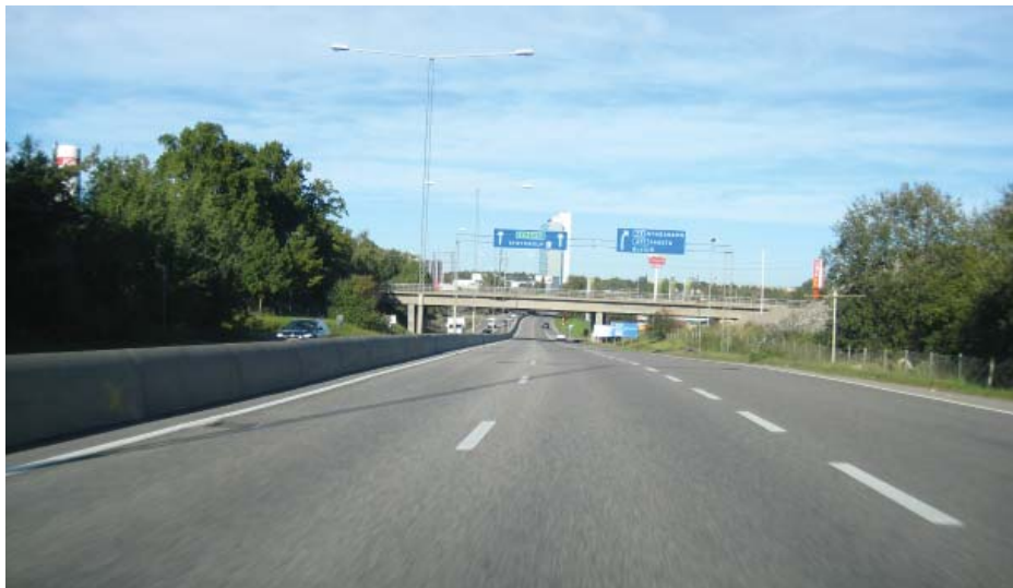
Huddingevägen vid Magelungsvägen, riktning norrut
