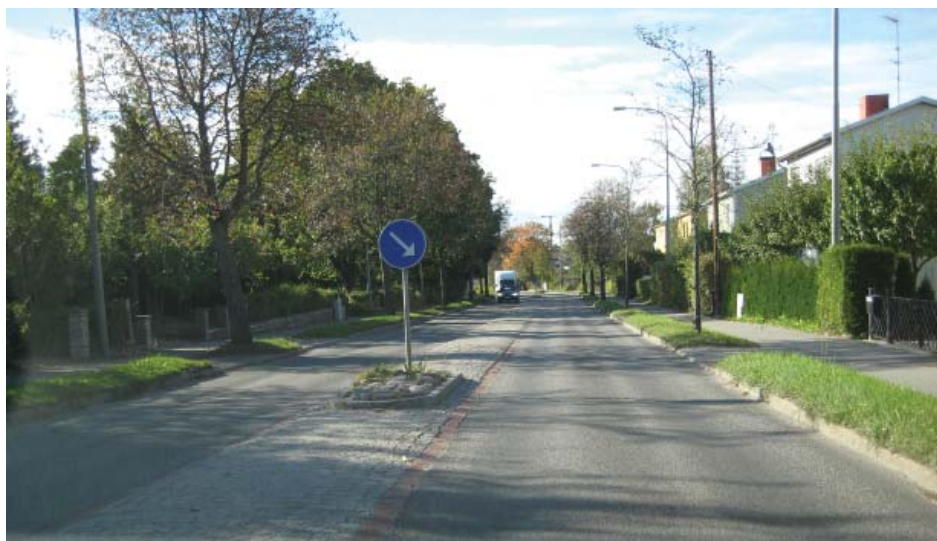
Bällstavägen vid Kyrkoherdevägen, riktning västerut
