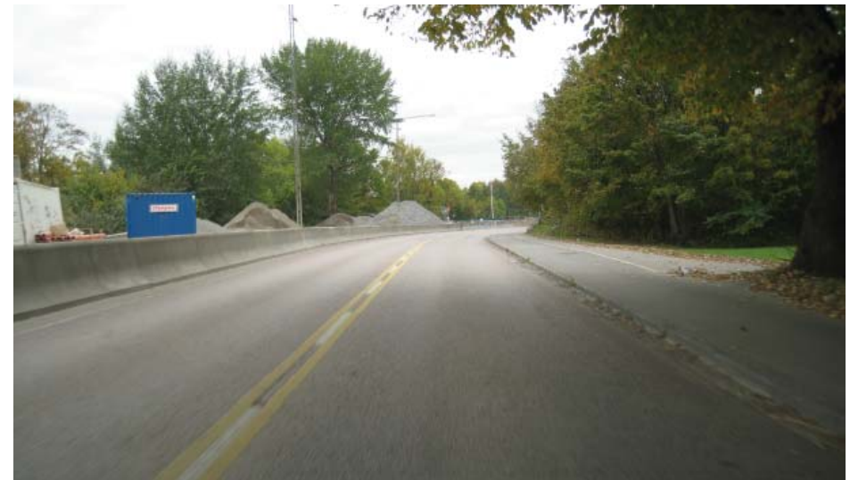
Johanneshovsvägen vid Bolidenvägen, riktning västerut
