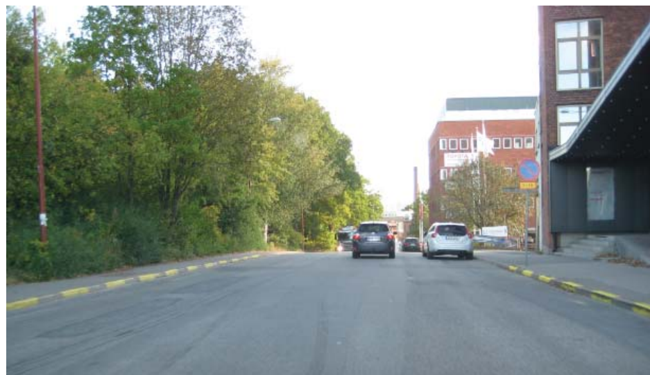
Voltavägen vid Norrbyvägen, riktning söderut
