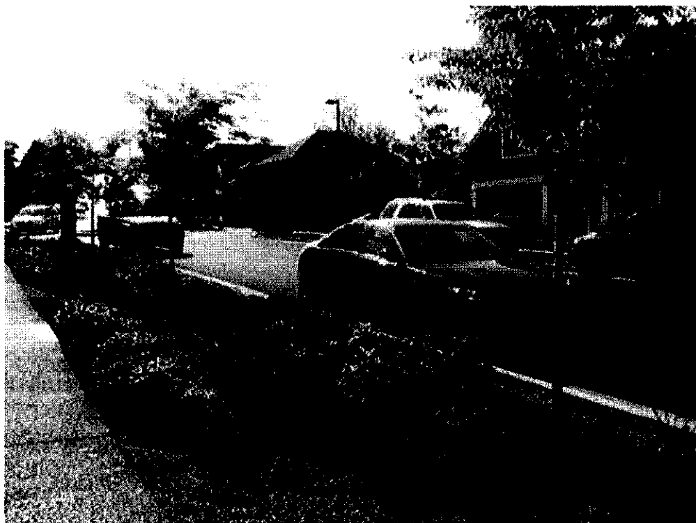
Figur 12. Svackdike med växter i gatumiljö, Seattle, USA. Från US Environmental Protection Agency
