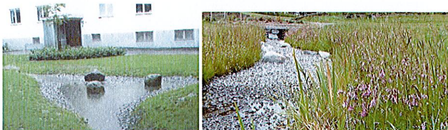
Figur 11. Öppet avvattningsstråk/översvämningssyta. (bild från Svenskt vatten P105 och Veg-Tech)
