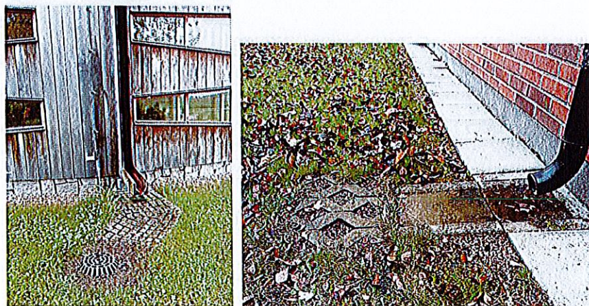
Figur 6. Utkastare till dagvattenbrunn respektive infiltration.
