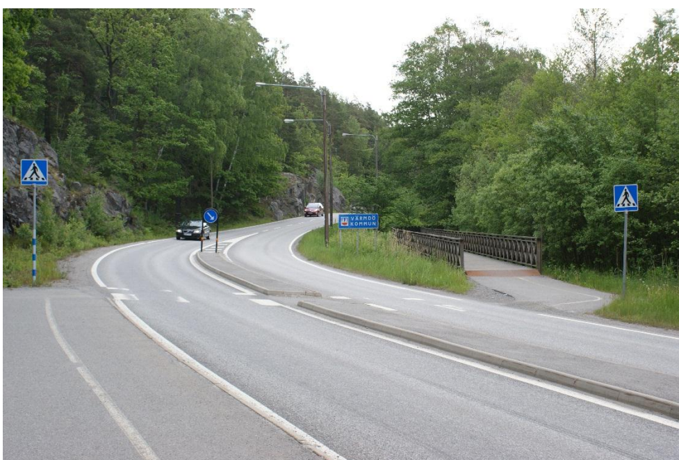
Det regionala cykelstråket i Värmdö. Träbroarna håller inte standard och är komplicerade att vinterväghålla då de handskottas. Passagen över Skärgårdsvägen är inte säker då den ligger i en kurva med dålig sikt och bör flyttas närmare Insjön i Nacka kommun
