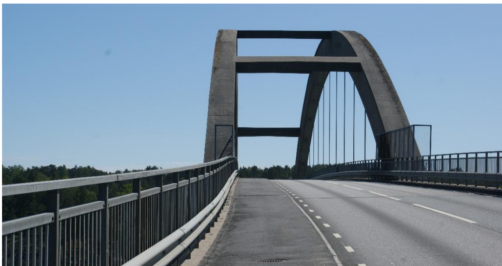
Gång- och cykelväg över Djuröbron
