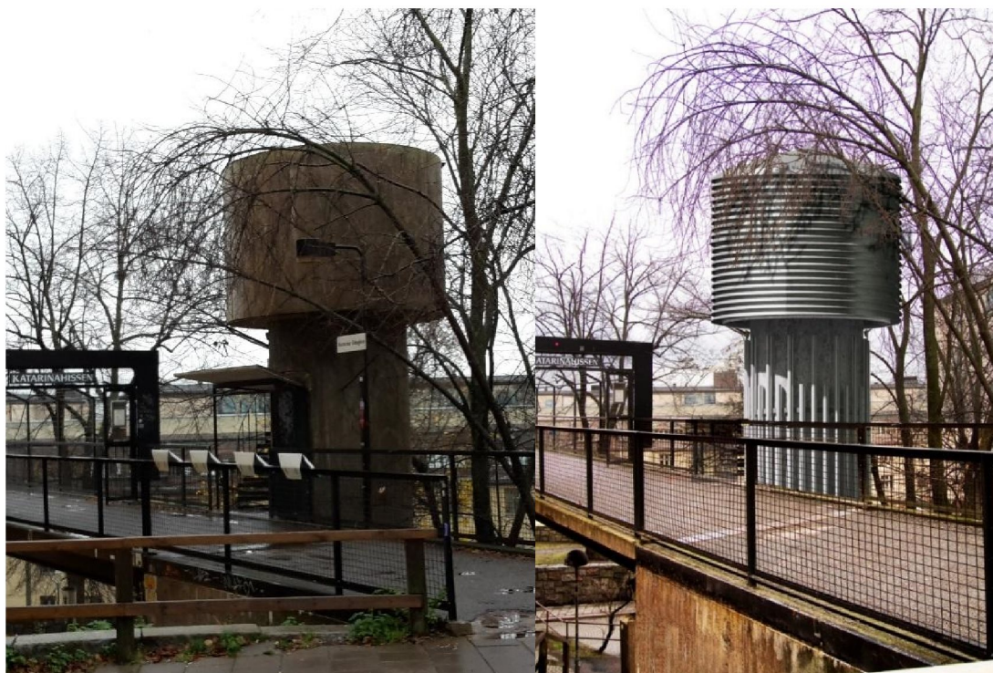
Figur 30. Till vänster foto av befintligt hisstorn (foto Tyréns) och till höger illustration efter ombyggnad. Illustration: Link Arkitektur.
