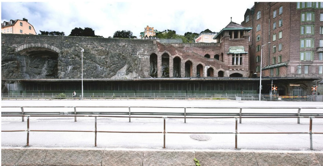
Figur 52. Foto som visar förkastningsbrant med stödmur och valv till vänster skärmtak. Längre till höger Lokattens trappor samt del av byggnaden inom fastigheten Tranbodarne 13. Foto: Tyréns.
