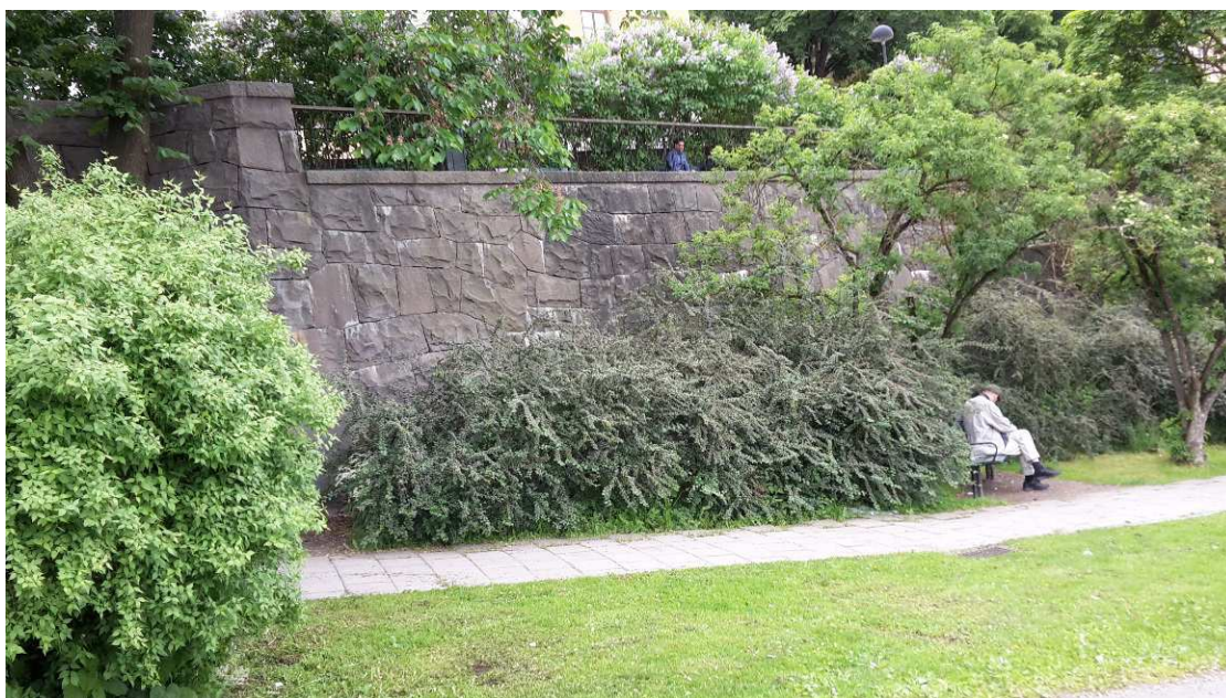
Figur 11. Befintlig gångväg, planteringar och stödmurar mellan Klevgränd och Glasbruksgatan. Foto: Tyréns.
