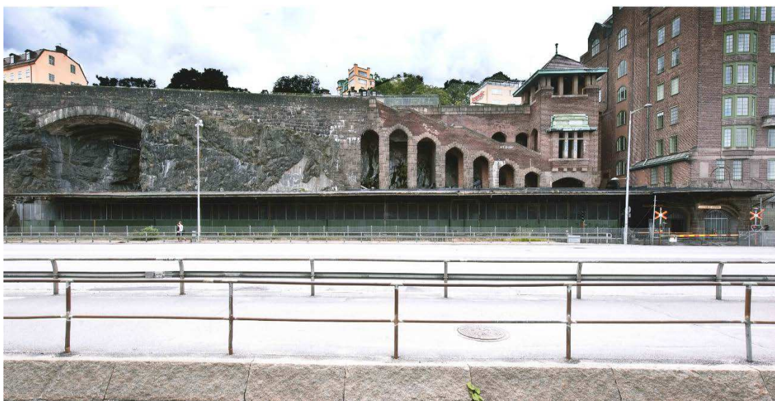
Figur 17. Foto som visar förlastningsbrant med stödmur och valv, skärmtak och Lokattens trappor samt del av byggnaden inom fastigheten Tranbodarne 13. Foto Tyréns
