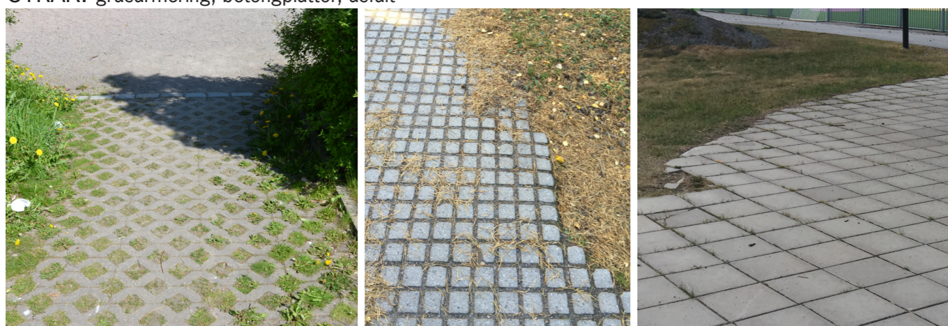
STRÅK: gräsarmering, betongplattor, asfalt
