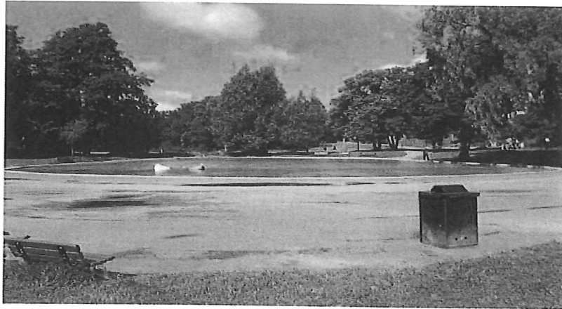
Fredhällsparken – mycket stor damm. Änder trivs. Töms under sommaren, kanske var 14:e dag. Markskador med pölar. Om möjligt bör de ses över. Omsättning och teknik (sandfilter) bedöms vara tillräcklig.
