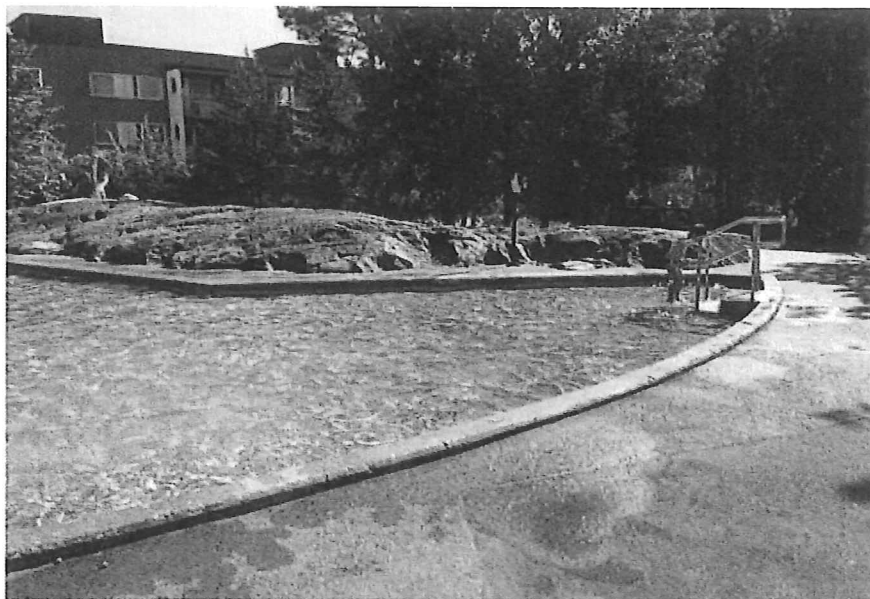
Husby V/Lofoten – dålig omsättning och dålig kröning från berghällen. Behöver renoveras.
