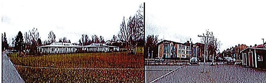
Bilden till vänster: omsorgsboendet Ängsgården. Bilden till höger: äldreboendet Trollängen samt bouleplan och parkering.
