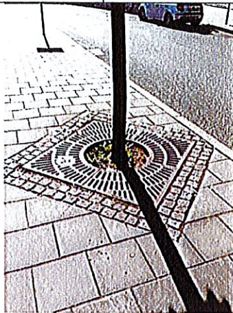
Figur 8. Träd som planterats i skelettjord dit dagvatten kan ledas och infiltrera.
