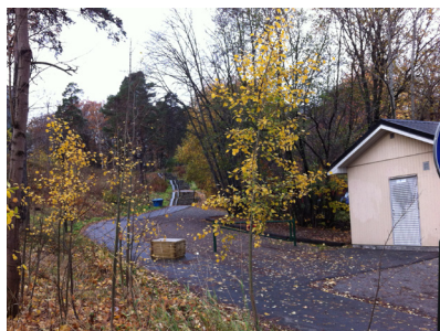
Stockholm vatten har en pumpstation som kan formas om till en parkbyggnad.
