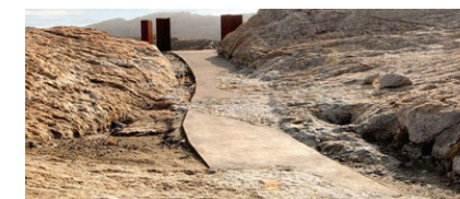
Gångvägar och sittplatser anpassas mot befintlig natur och hällmark. På bilden ett exempel på hur betong kan användas mot berg.
