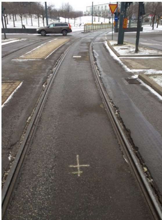
Sydgående spår i Hammarby Allé, in mot Lumaparken.
