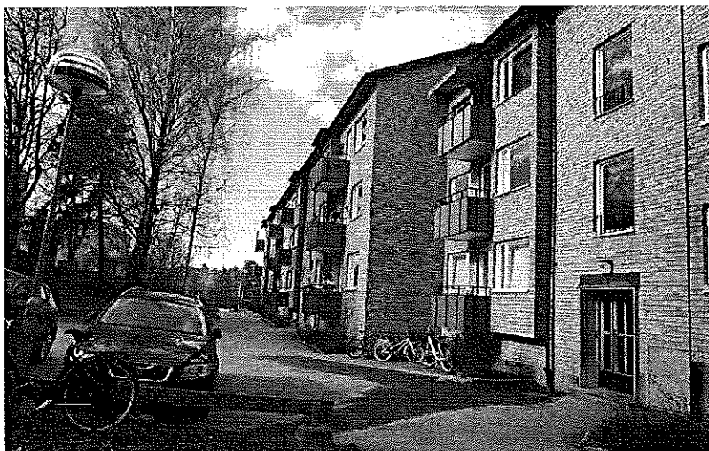
Bebyggelse på fastigheten Lådkameran 3.
