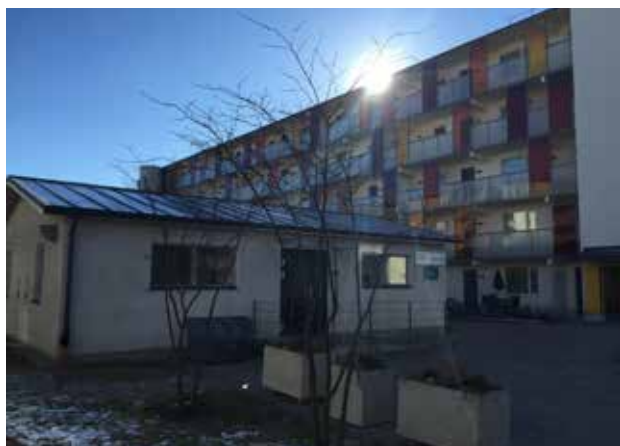
Byggnaden som inrymmer tvättstugan på fastigheten Molde 2.
