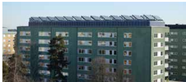
Vesterby backe 26. Denna anläggning är i kombination med solvärme. Här är modulerna monterade som en hockeysarg runt huset, även mot norr
