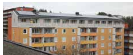
Oslogatan 38 var den anläggning som hade högst uppmätt produktion per kW, 958 kWh/kW och år.
