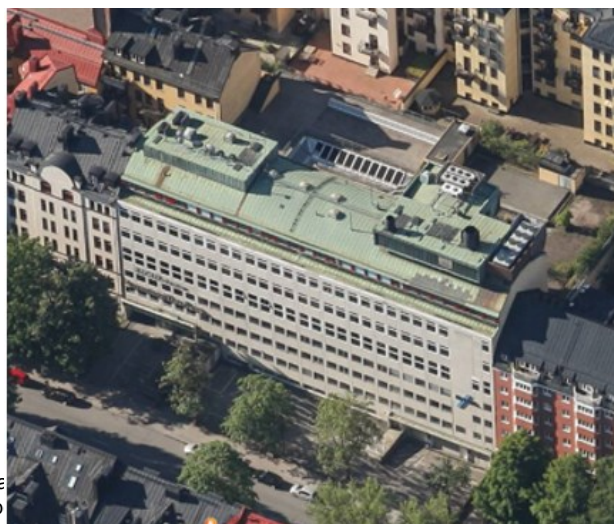
Bild: Fasaden mot Karlbergsvägen på fastigheten Kadetten 29.
