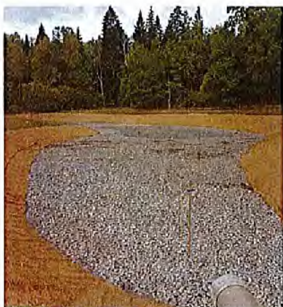
Del av dagvattenanläggningen i Prästängen under utförande.
