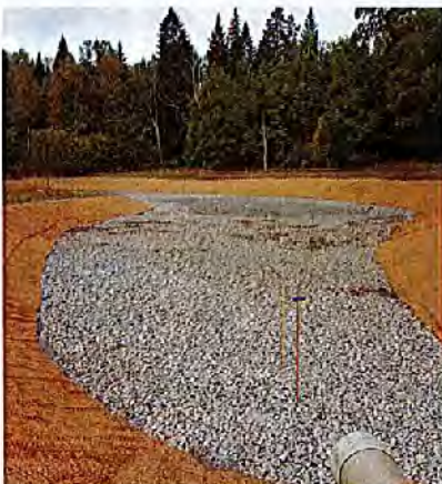
Del av dagvattenanläggningen i Prästängen under utförande.
