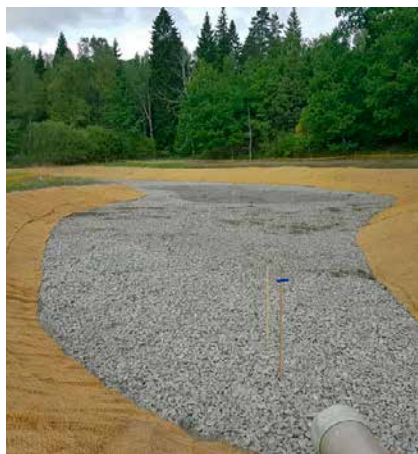
Del av dagvattenanläggningen i Prästängen under utförande.
