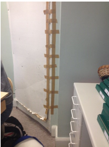
Figur 6. Deplacerat tilluftsdon förtäckt på grund av drag
